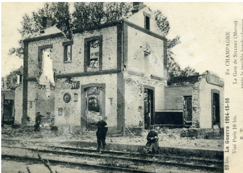
Photo de 1916, durant la guerre. La gare a été détruite par les bombardements. Les premières lignes ennemies sont à 1300 mètres.
